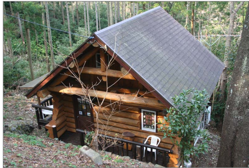
平成5年築の建物
